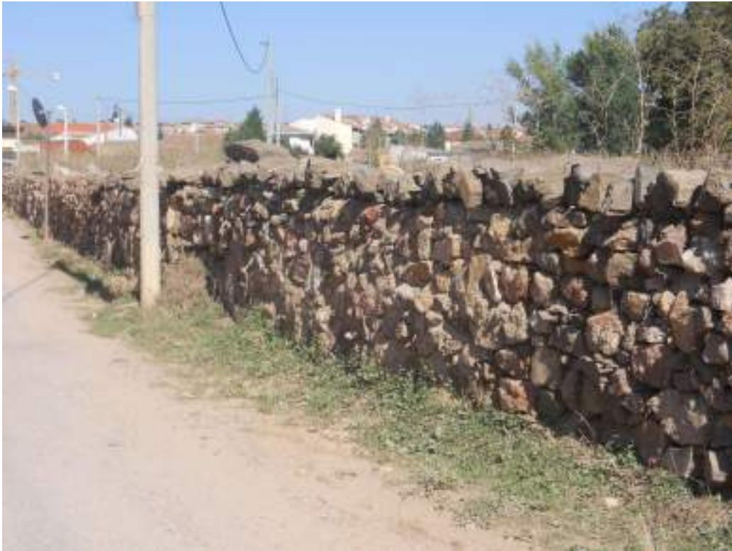
Foto 1: Muro de piedra
