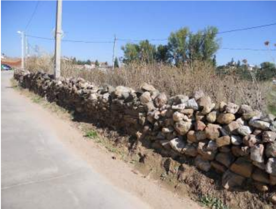
Foto 1: Muro de piedra
