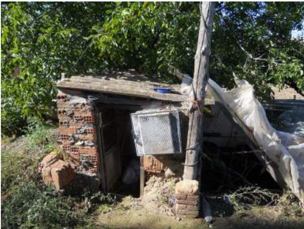
Foto 2: Pozo e instalación de bombeo
